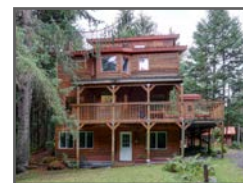
191 Agostino Mine Rd.
